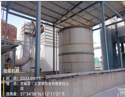
6#回转窑、7#回转窑配套氨水罐
