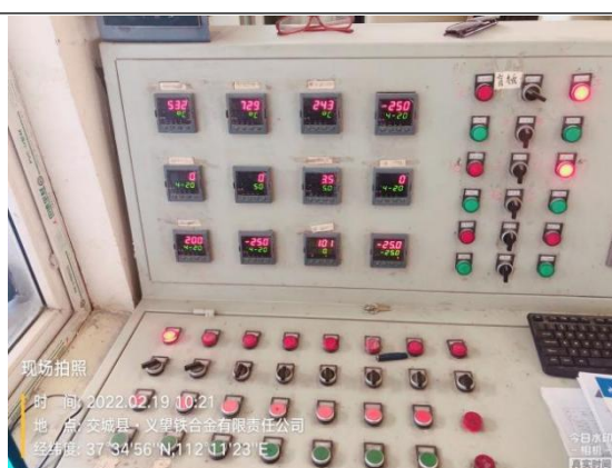
7#石灰石回转窑 DCS 控制系统及控制柜
