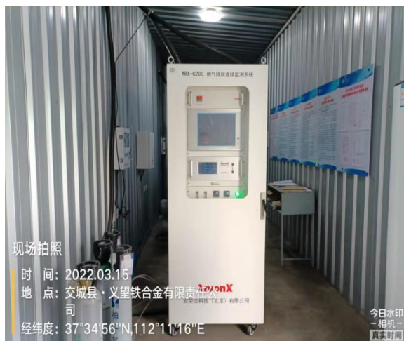
6#锰矿烘干回转窑在线监控设备
