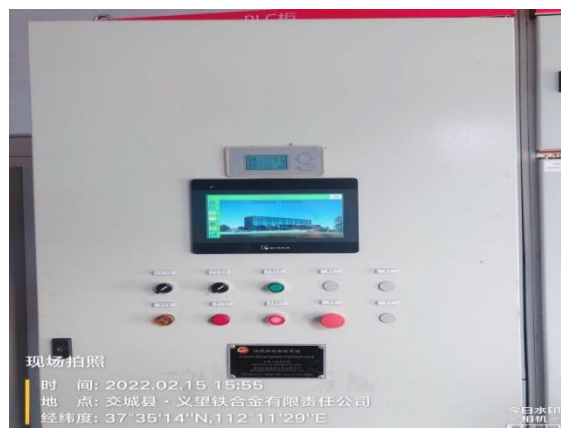
3#石灰石回转窑脱硫脱硝系统 PLC 控制系统及控制柜
