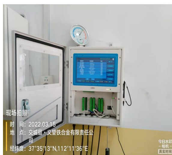
4#锰矿烘干回转窑在线数控单元
