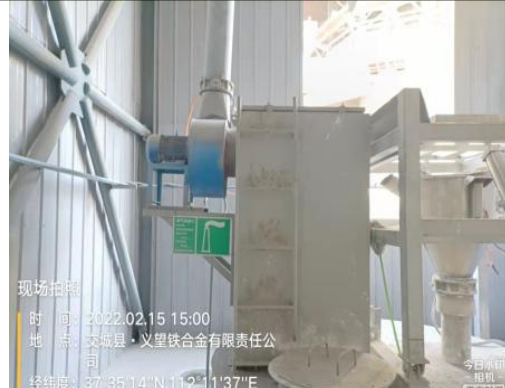
4#、5#回转窑配套脱硫剂料仓及其除尘器
