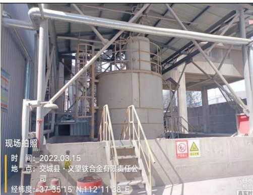
4#回转窑、5#回转窑配套氨水罐
